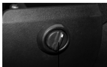
Vred för värmepump i öppet läge
