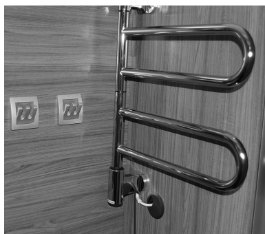
Brytare för att slå på och av handdukstorken sitter i nederkant.
