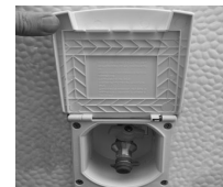
Utvändigt gasoluttag
