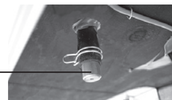
Avtappningsplugg vid ytterdörr/under panna
