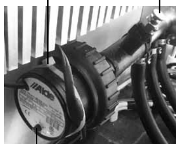
Vred för reglering av pumpens hastighet
