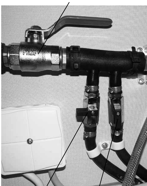
Kran för bakre golvvärme-slinga. Visas i stängt läge Kran för främre golvvärme-slinga. Visas i öppet läge
