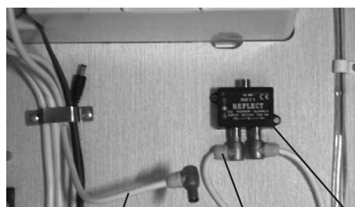
Från kabel-TV ingång Till fördelningsdosa Antennförstärkare
