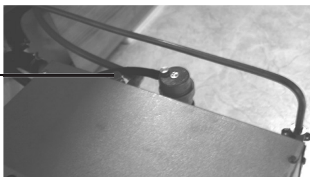
Luftskruv varmvattenberedare
