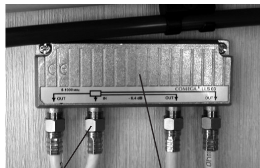
Ingång TV-fördelningsdosan
