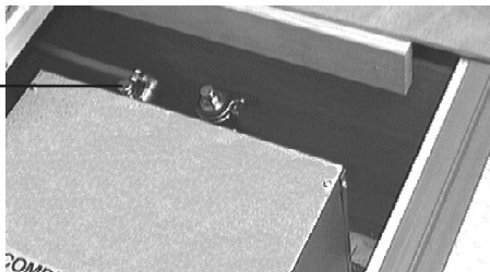
Luftskruv varmvattenberedare Aldepanna
