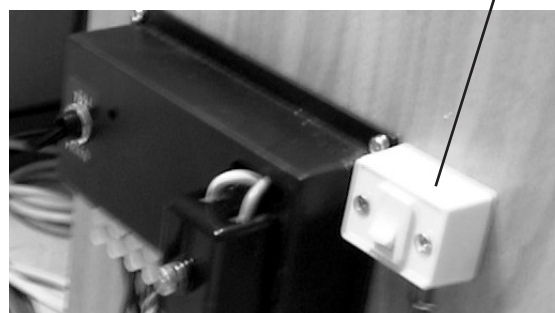
Strömbrytare fläktkonvektor
