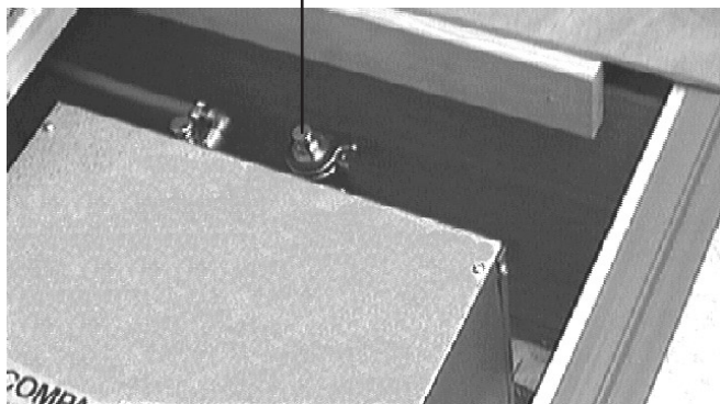
Luftnippel värmesystem
