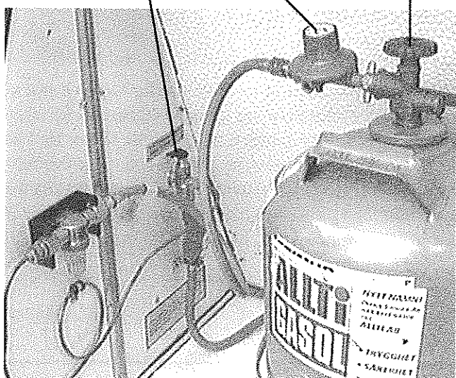
Avstängningsventil för gasol till gasolpanna Reduceringsventil Huvudkran
