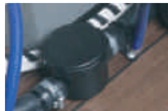
Vattenlåset till gråvattentanken
