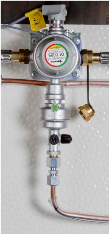
Gasolomkopplare kopplar automatiskt om till reservflaskan, när den första tar slut.
