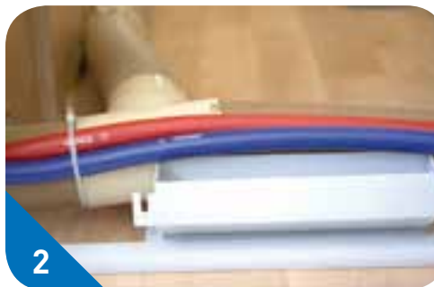
2 Frostskyddade vattenslangar.
