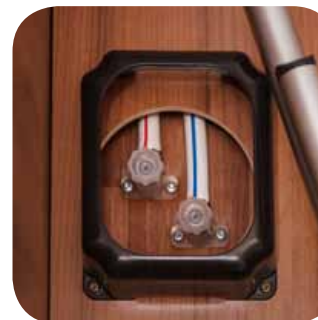
Skyddade ventiler i stuv- utrymmet under sängarna.
