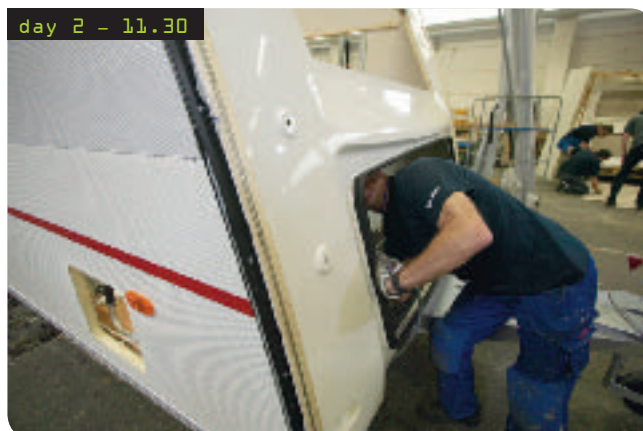
Dag två, kl 11.30 – Cabby är i ledningen. Alla ledningar och kablar placeras ut, och i den rymliga kofferten fram förbereds genomföringarna för gasolen.
