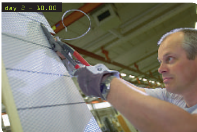
Dag två, kl 10.00 – Ett klipp. Innan väggarna kan fogas samman klipps plåten rent för att passa exakt. Skarvarna tätas därefter med en fuktavvisande och elastisk fogmassa.
