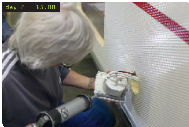
Dag två, kl 15.00 – Cabby håller tätt. Elkablage, kontakter och gasolrör dras fram. Mycket av det som gör Cabbyn bekväm, praktisk och rymlig finns i det fördolda. Metervis med kablar och rör göms finurligt undan för att inte störa helhetsintrycket. Alla ingångshål i karossen tätas effektivt med tätningsmassa.
